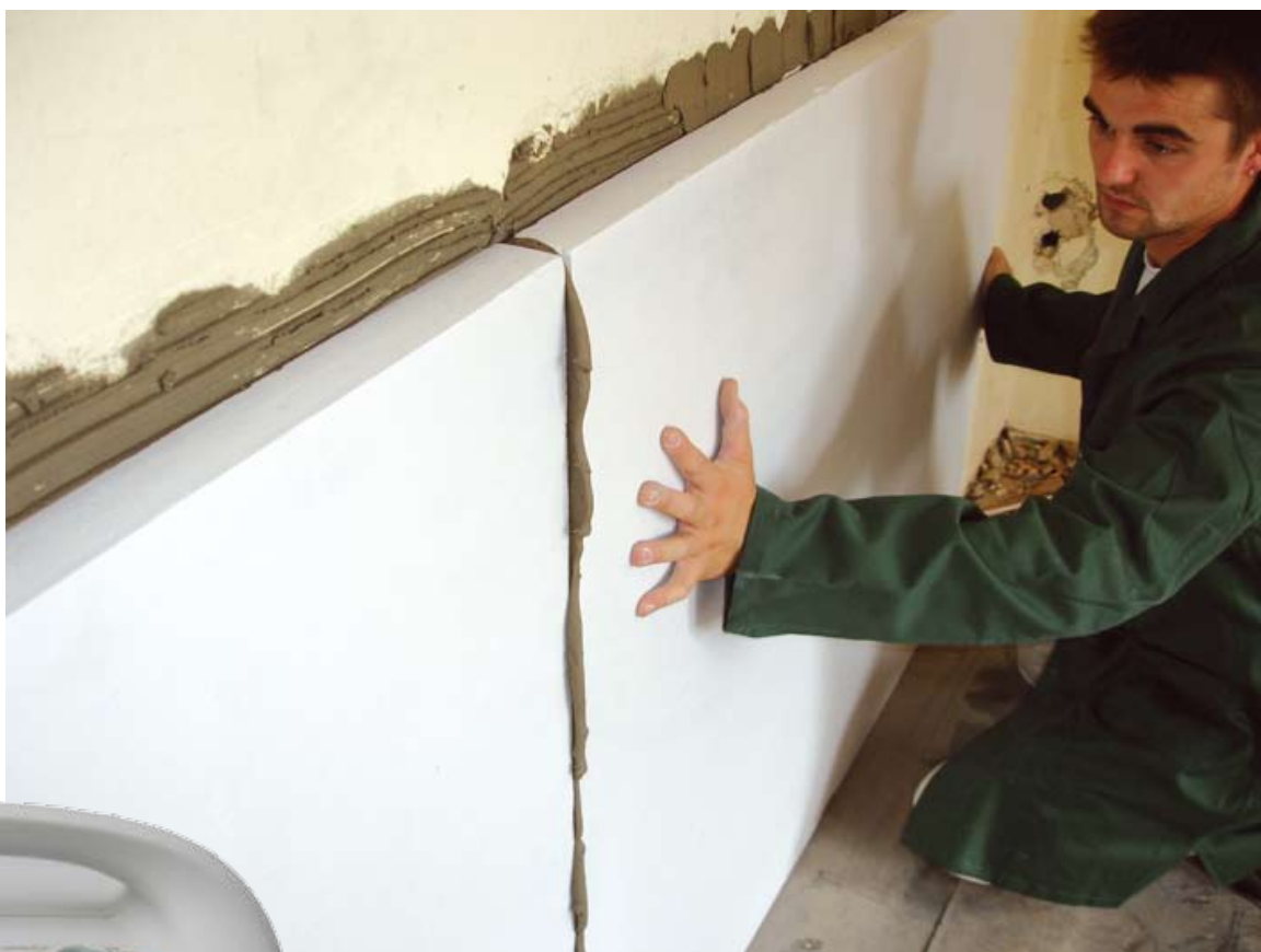
Die Lösung für die Zukunft: Eine Innendämmung aus Calciumsilikat-Klimaplaten reguliert die Raumfeuchtigkeit und sorgt für ein gesundes Klima.
