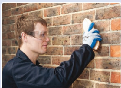
Lösen Mörtel, Staub und Schmutz mit einer Fassadenbürste entfernen.
