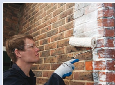
StormDry mit einer Rolle oder Pinsel auftragen. Die Gefahr Fenster oder Türen zu verschmutzen ist minimal.
