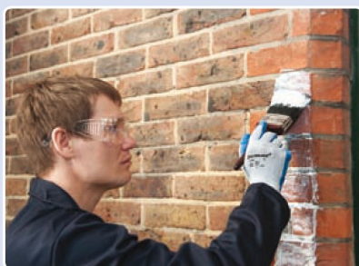
StormDry mit einer Rolle oder Pinsel auftragen. Die Gefahr Fenster oder Türen zu verschmutzen ist minimal.
